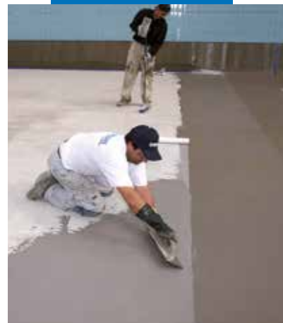
Peldbaseina hidroizolācijas izveide, izmantojot Mapelastic
