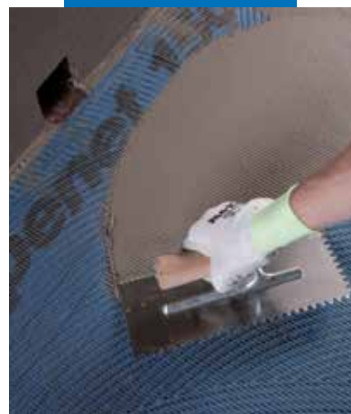
Mapelastic pārklājuma izveide uz Mape-net 150.
