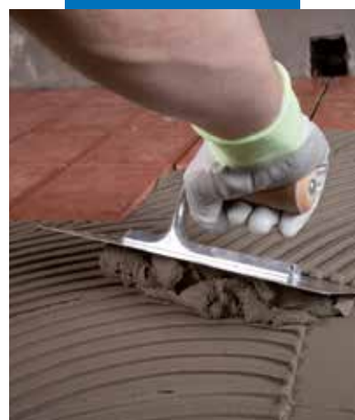
Fližu instalēšana ar Granirapid pēc balkona hidroizolācijas izveides ar Mapelastic
