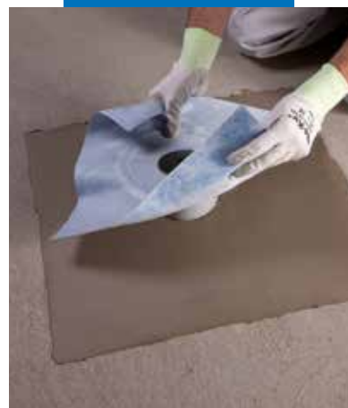
Drain Vertical iestrāde uz Mapelastic slāņa
