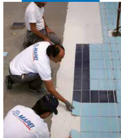
Keramisko flīžu instalēšana peldbaseinā pēc hidroizolācijas izveides ar Mapelastic
