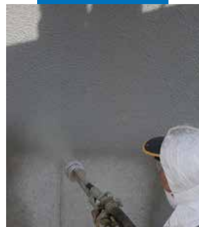
Mapelastīc uzklāšana uz tilta betona konstrukcijām ar augstspiediena pulverizatoru
